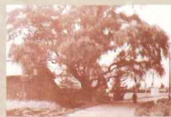
昭和25年頃の樺戸道路(峰樺付近)。
