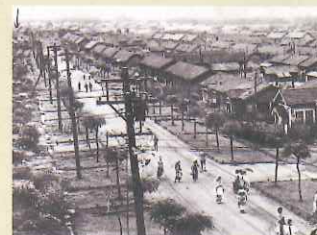
三井美唄炭鉱住宅街大通り付近（昭和16年）。丘陵地を基盤の目に区画して条丁目を設定し、住宅の周囲には花壇用地まで配した近代的なものでした。
